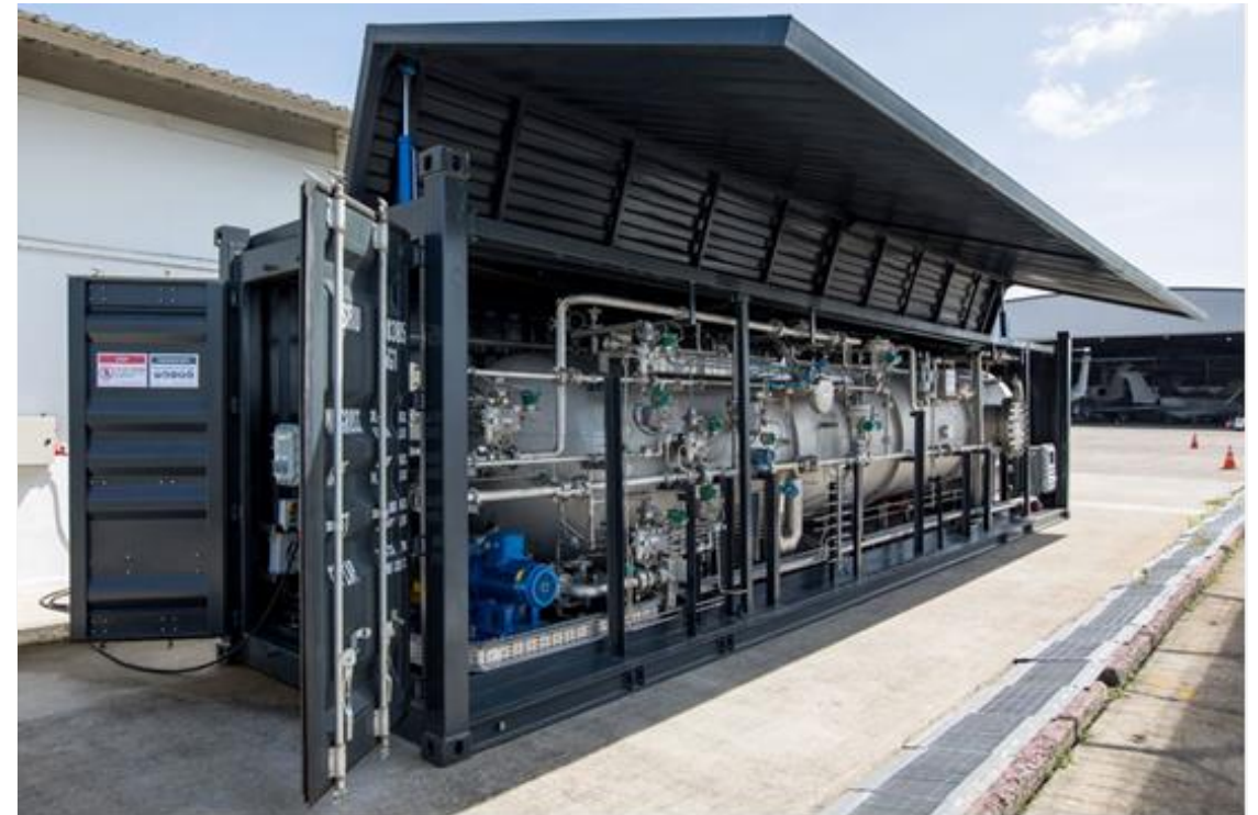
Vollständig integrierte, eigenständige Tankstelle für synthetische Kraftstoffe
